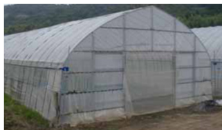
パイプハウス
