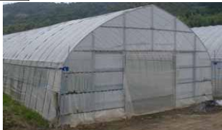
パイプハウス
